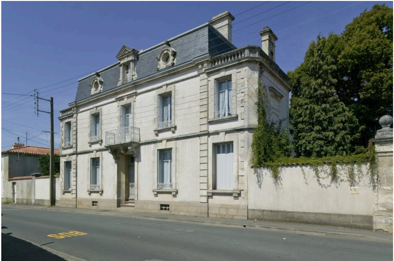
Façade sud, donnant sur l'avenue, de la maison.
