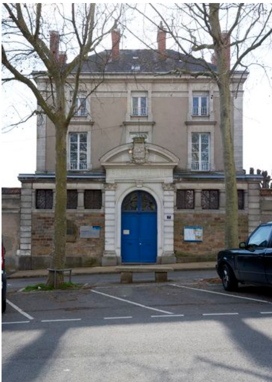
Façade côté rue de l'ancienne école de garçons.
