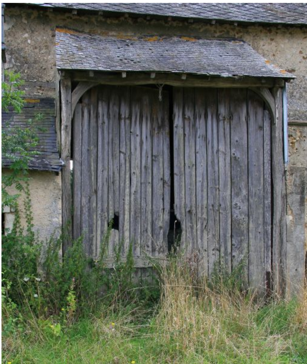
La grange, façade postérieure, détail : la porte de sortie.
