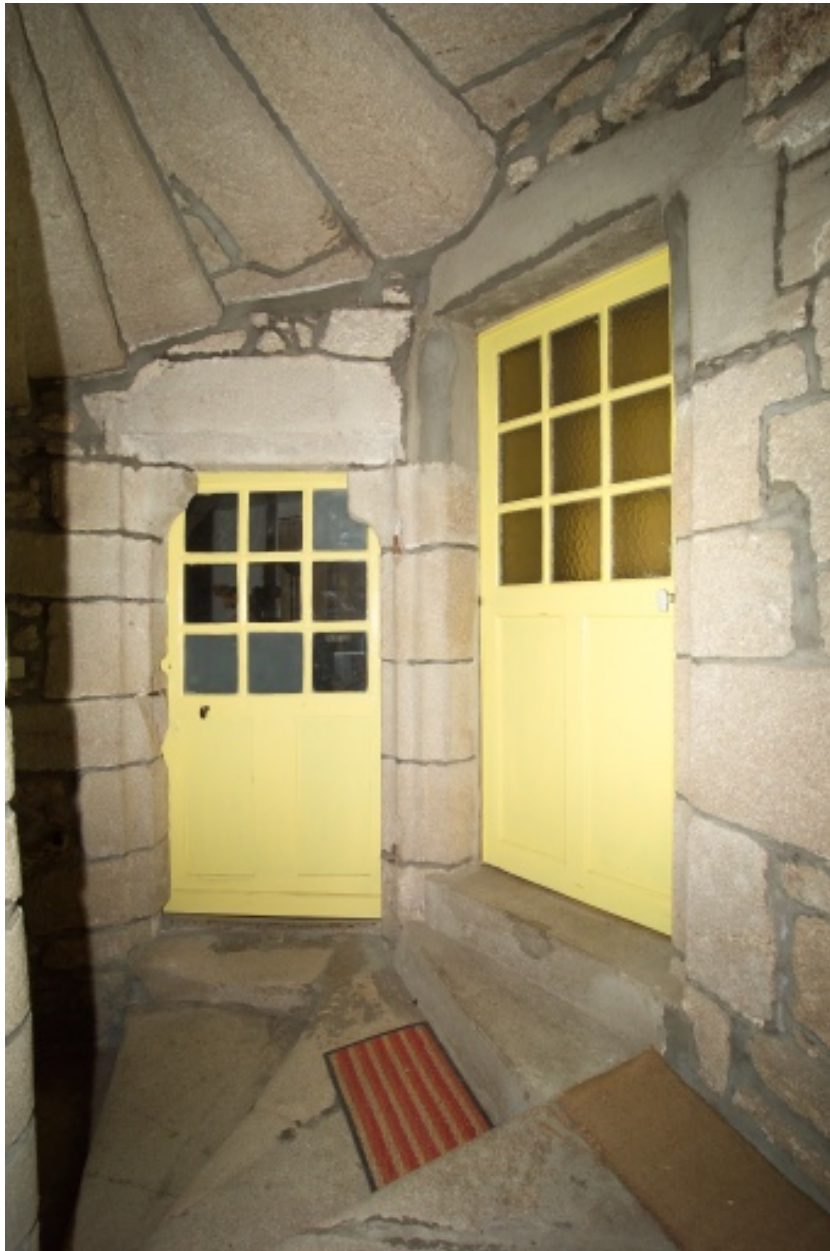
Cage d'escalier, porte ouvrant vers les salles sur rue.
