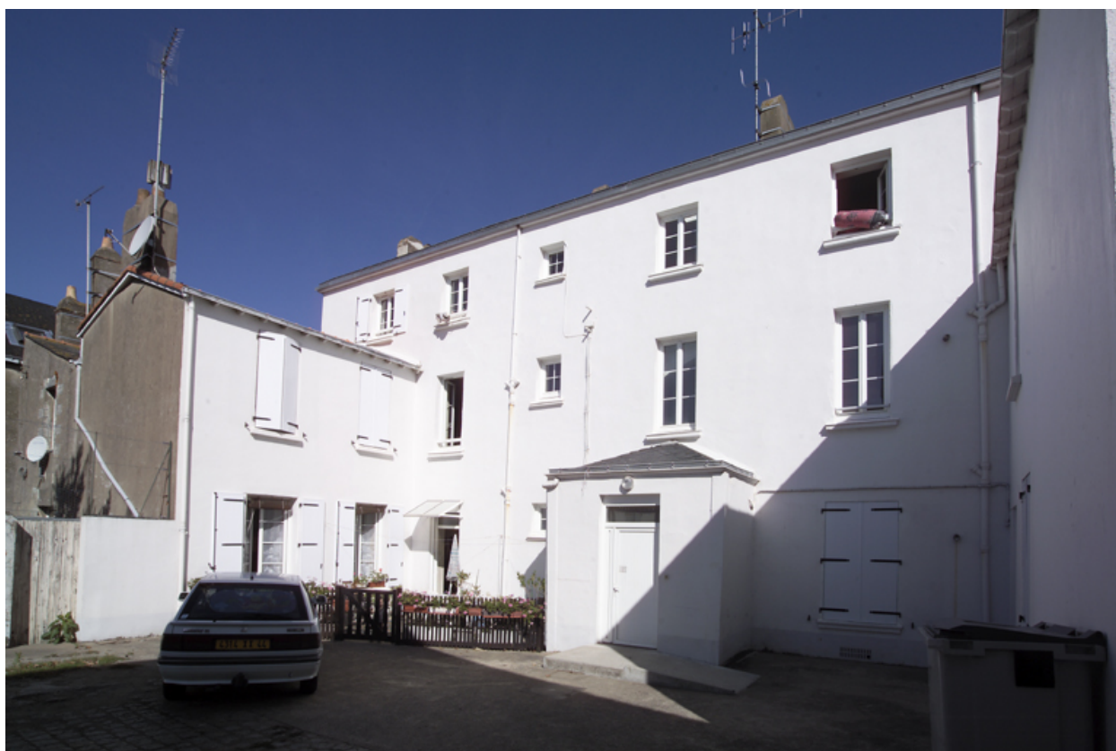
La façade postérieure.
