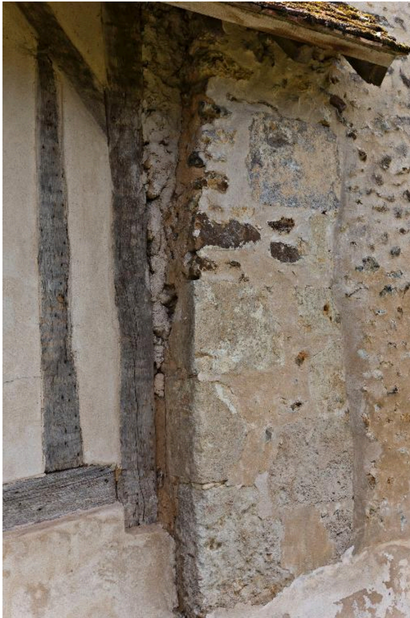
Détail de l'élévation antérieure du logis de la ferme 1 : jonction du mur-pignon portant la cheminée et du pan-de-bois.
