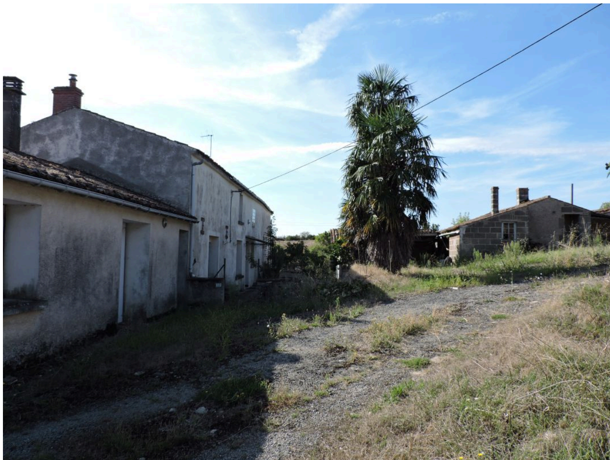
Les bâtiments vus depuis le nord.
