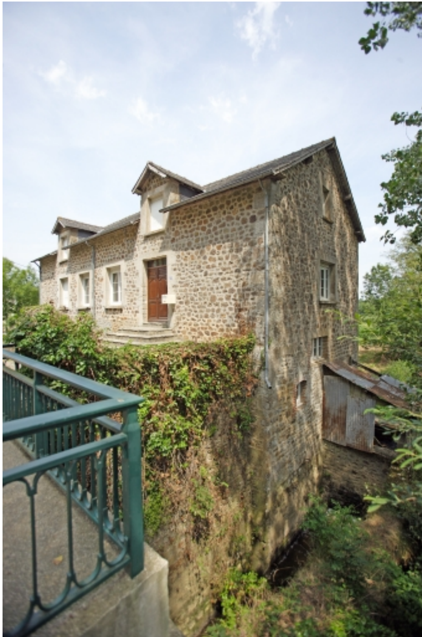
Le moulin de Sept-Forges (Orne) vu depuis le pont au sud-ouest.
