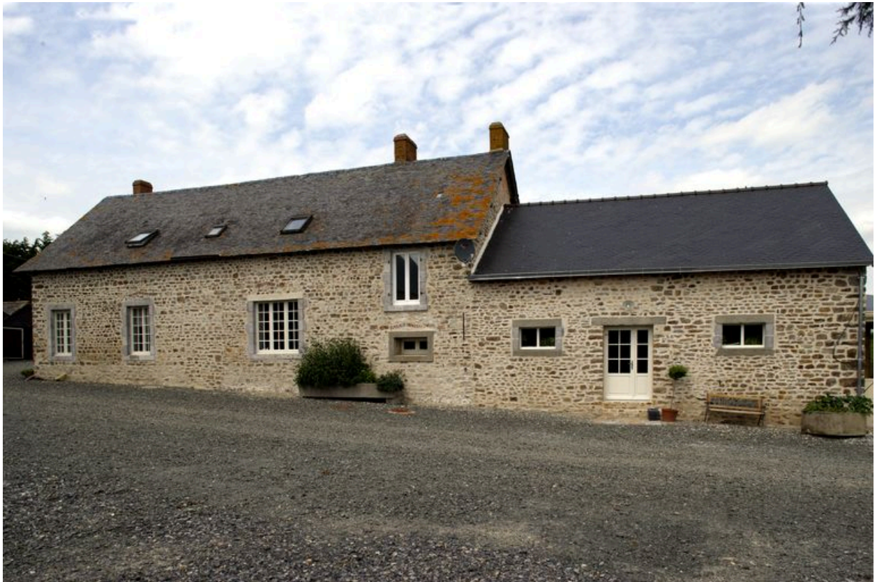
Le logis vu depuis le sud.
