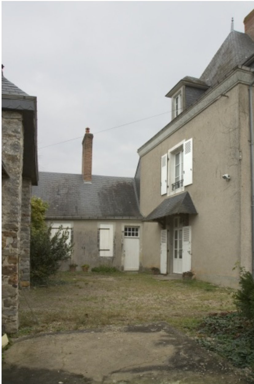
L'élévation ouest du logis et le corps de bâtiment de l'ancienne cuisine vus depuis le sud.
