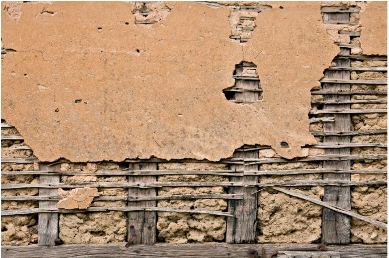
Détail du pan-de-bois enduit de la grange.
