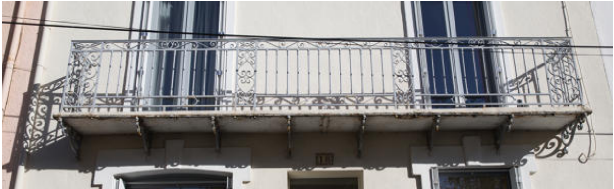
Maison, 18 quai Henri-Brunais. détail du balcon filant de l'étage carré.
