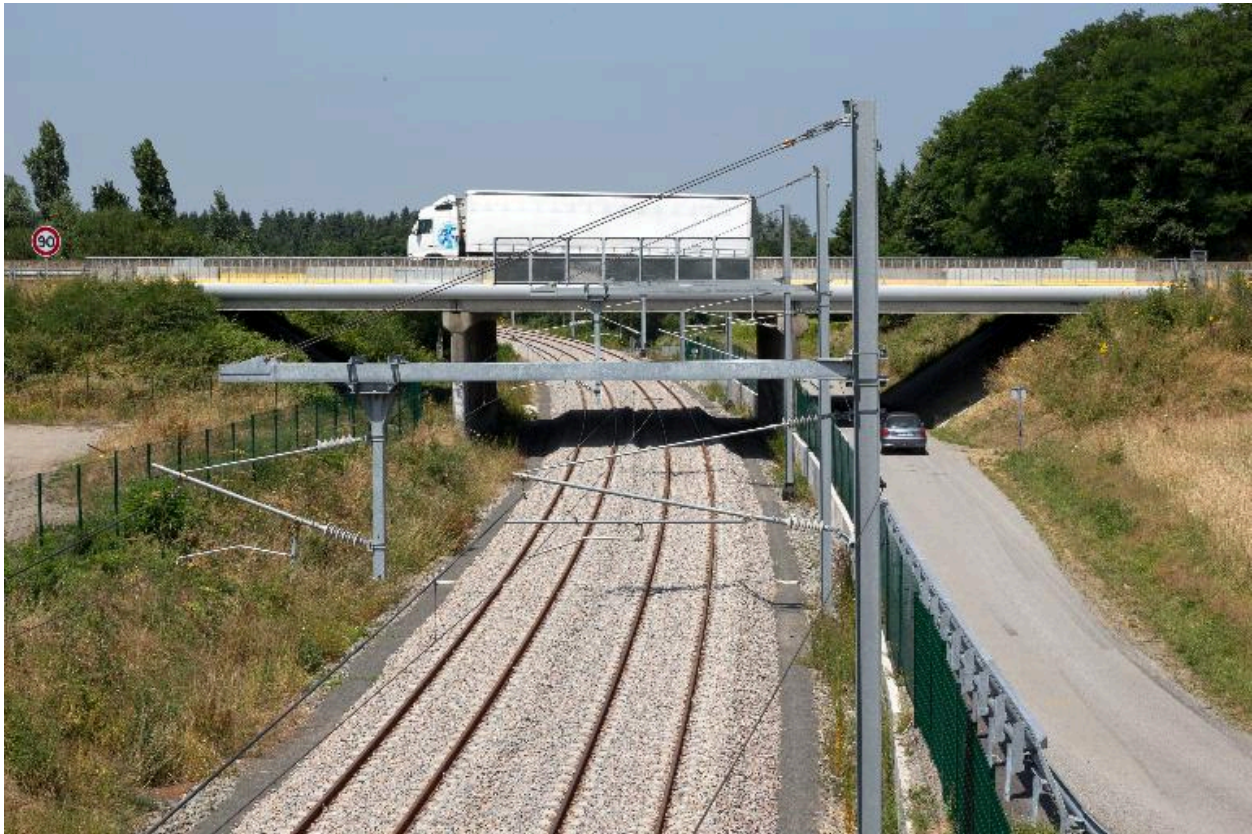
Pont en 2013 après les travaux sur la voie.
