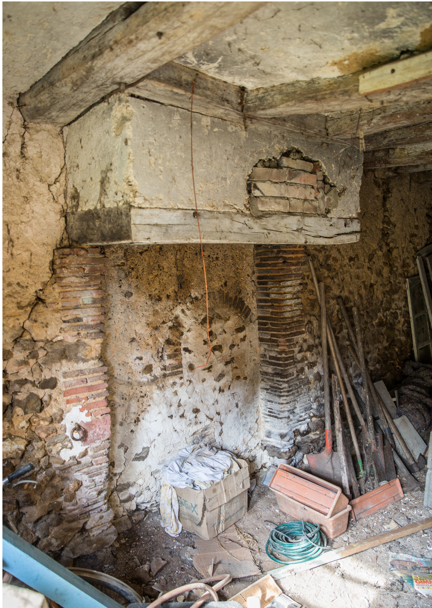
Un détail d'une cheminée avec four muré, ruelle de la Hulotterie.
