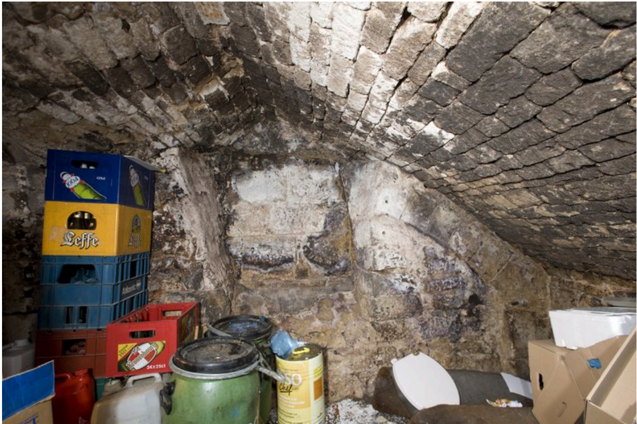
Sous-sol du 12, place des Acacias : vue prise du nord.
