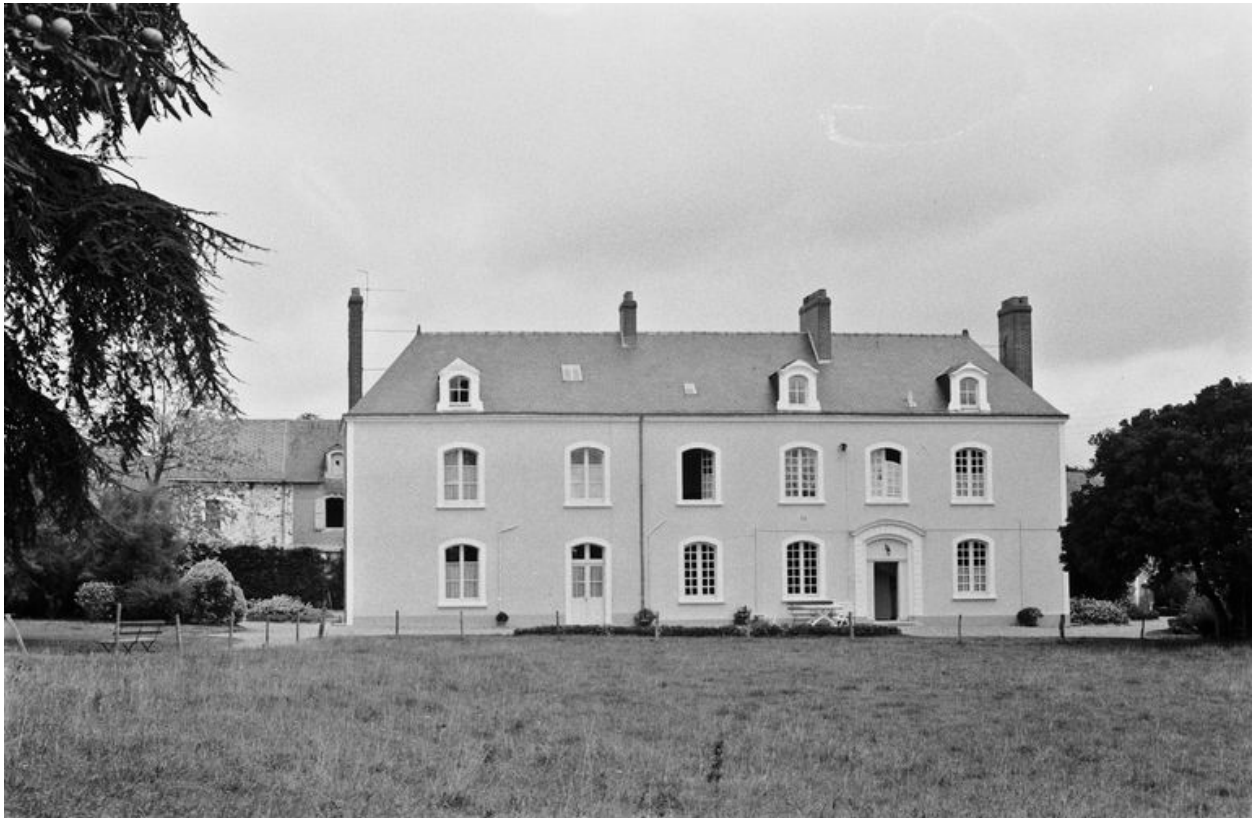
Façade donnant sur la Sarthe.
