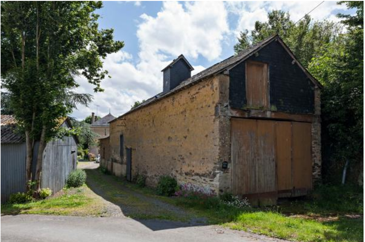
L'ancien entrepôt à grains vu depuis le nord.
