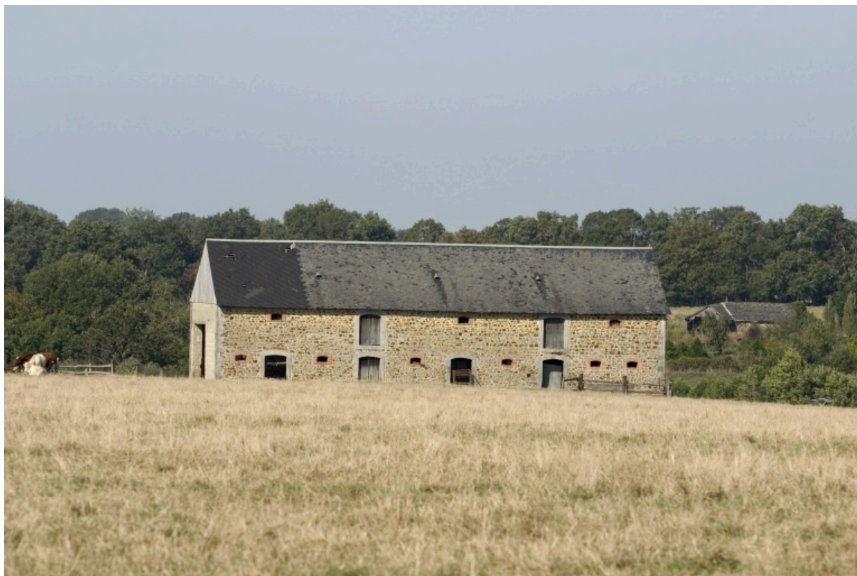
L'étable-grange vue depuis le chemin menant à la Billerie, à l'est.
