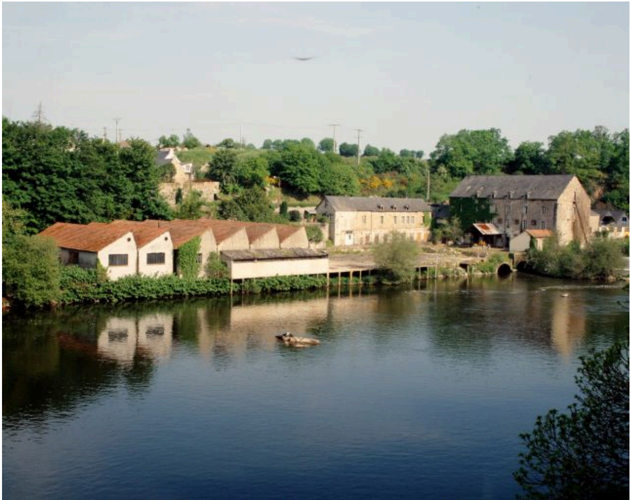
Vue d'ensemble de l'usine d'amiante.
