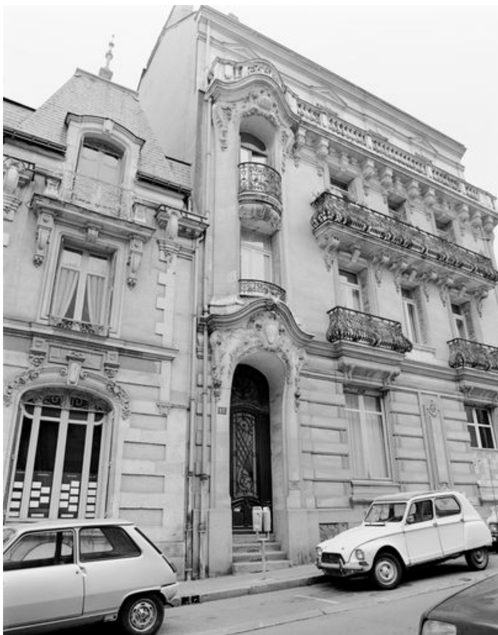
Façade sur la rue Saint-Martin, travées gauches.
