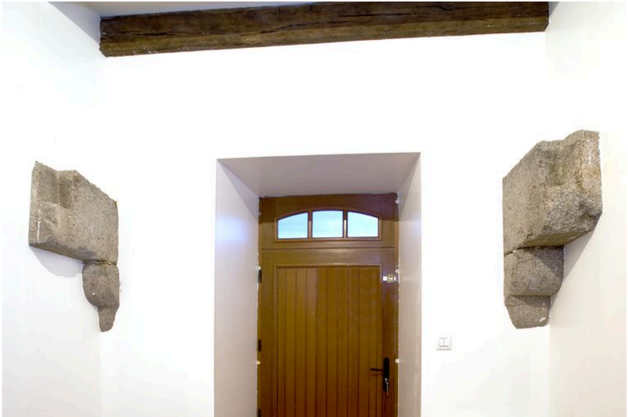
Les vestiges de la cheminée après le dégagement de l'enduit.
