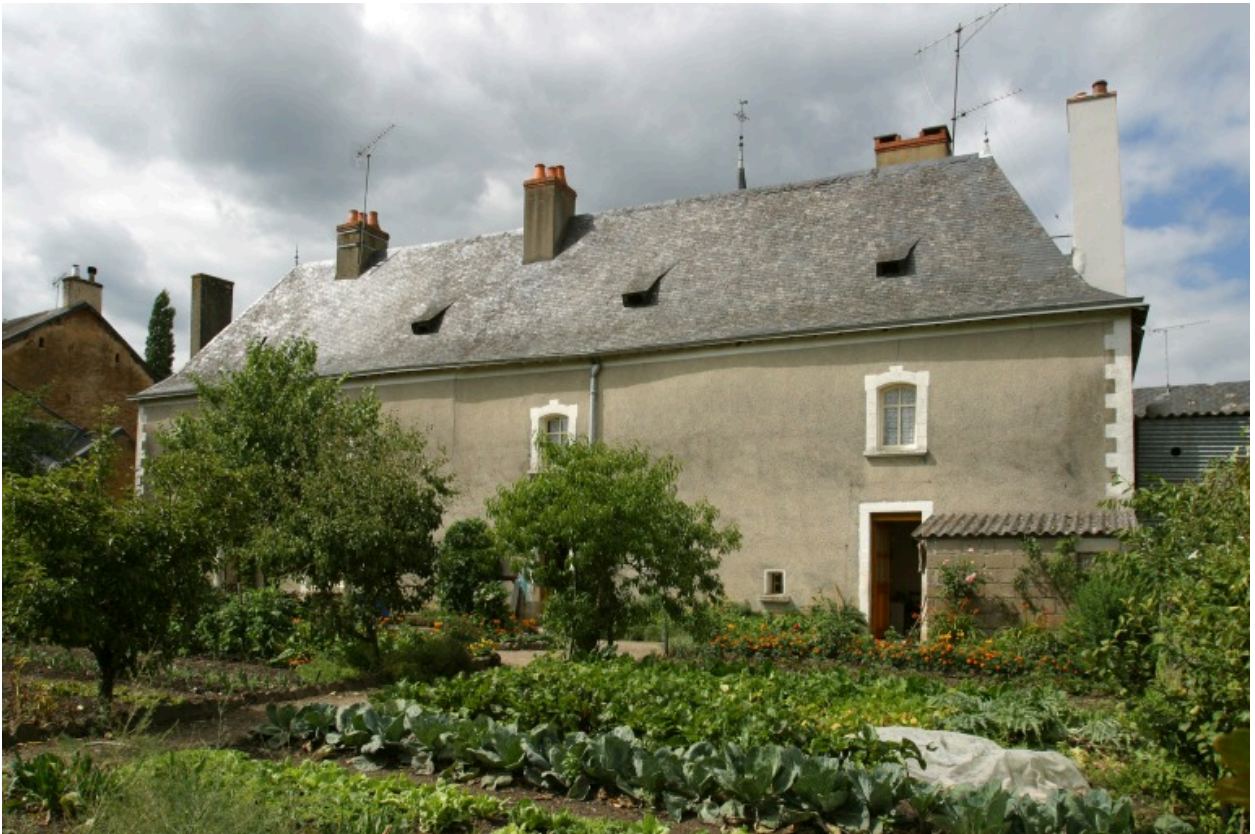
Le corps central vu depuis le jardin au sud-est.
