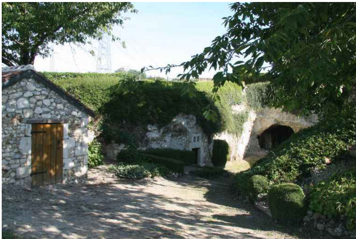
Etage des anciennes maisons troglodytiques.
