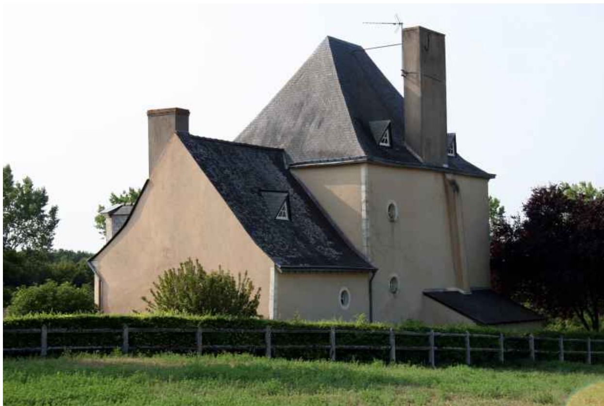
Vue de volume de la façade postérieure.
