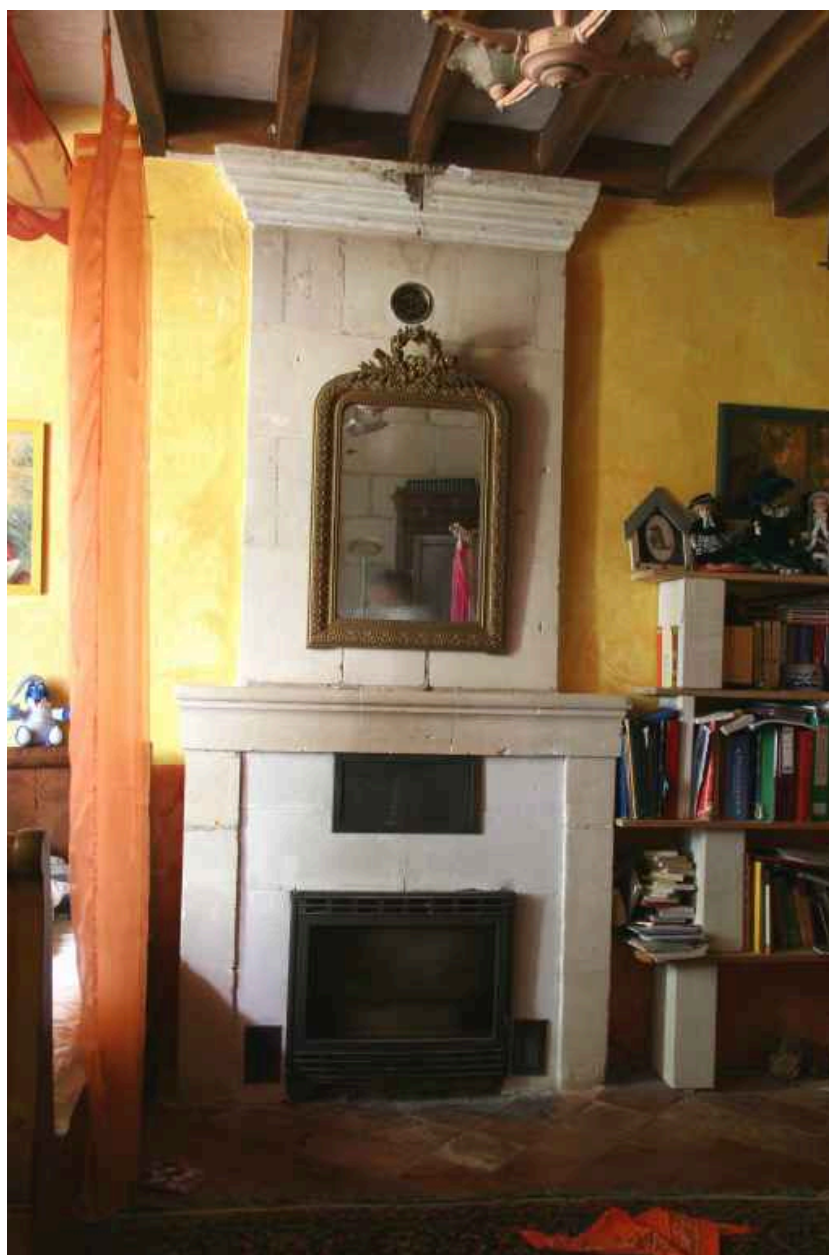
Cheminée de la chambre placée à l'extrémité gauche.
