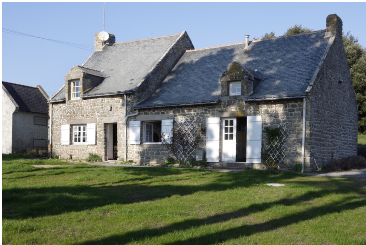
Vue de la maison du gardien depuis le sud.
