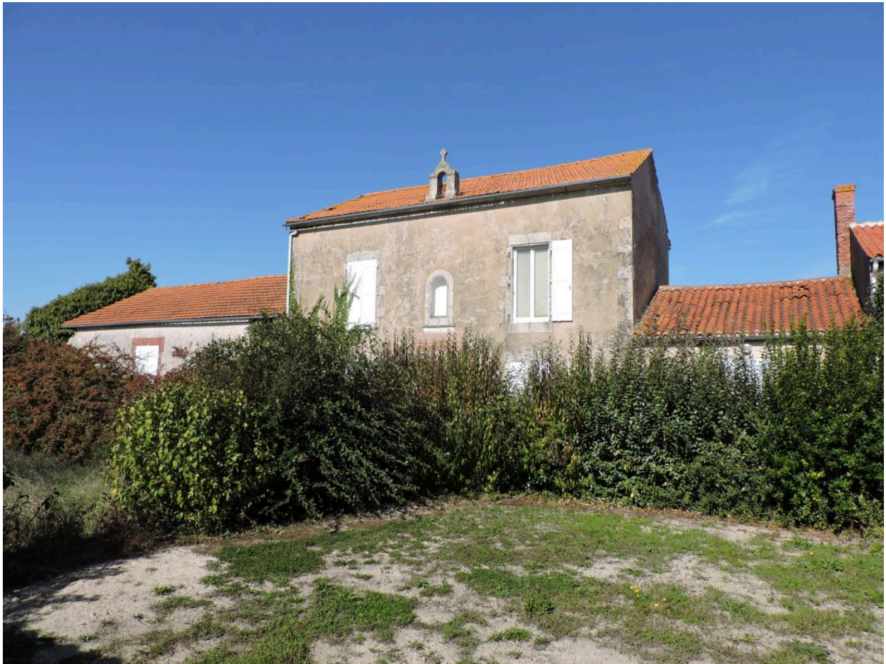
L'ancienne école vue depuis le sud.
