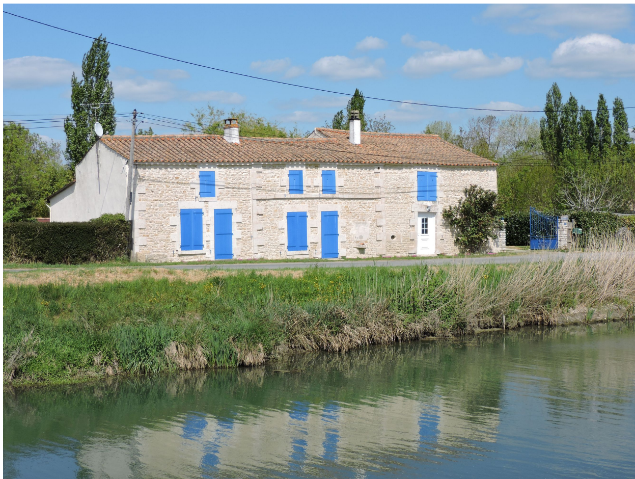
L'ancienne ferme au bord du canal du Nouveau Bézou, vue depuis le sud-ouest.
