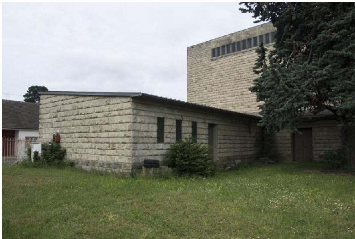
Vue de la sacristie en extérieur.
