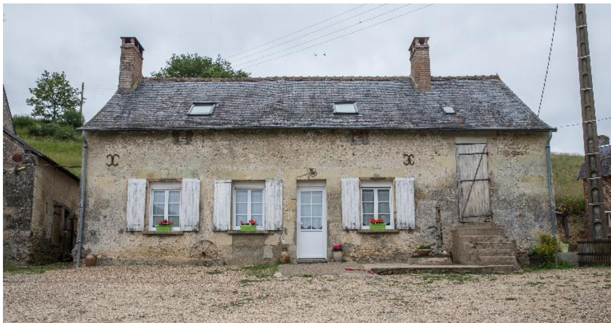
Logis, façade sud sur cour.
