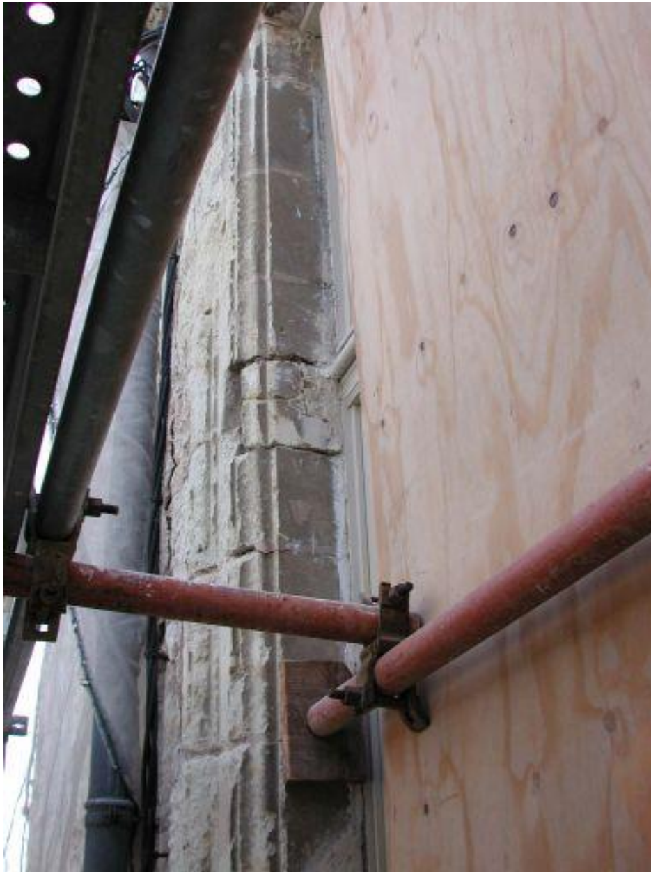
Corps de logis sud-ouest, fenêtre d'étage gauche sur rue : détail sur le jambage gauche avec trace de la traverse de croisée en pierre (travaux nov. 2002)
