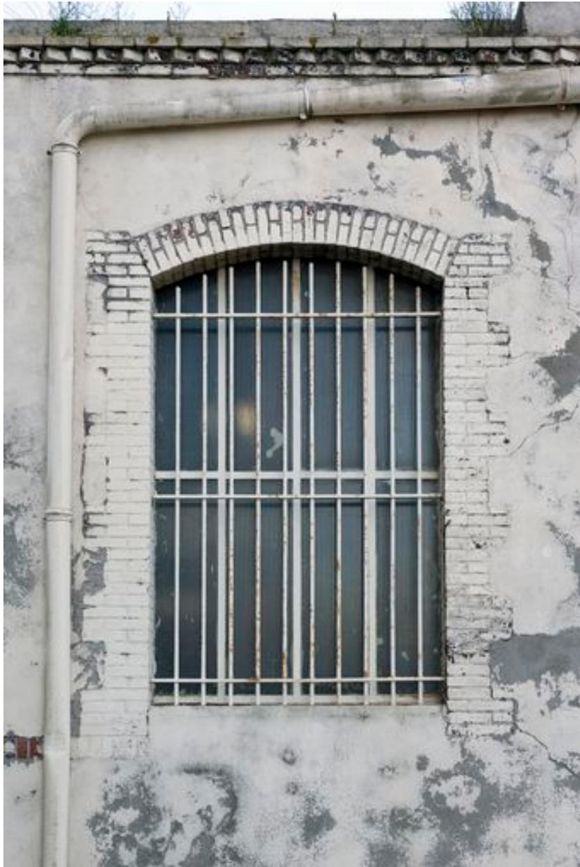
I : détail des ouvertures du bâtiment construit au début du XXe siècle désaffecté, linteau et chaînage en briques.
