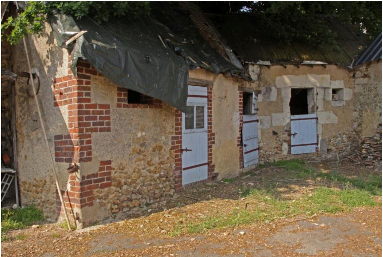
Toits à porcs à fleur de coteau, en retour d'équerre de la buanderie.
