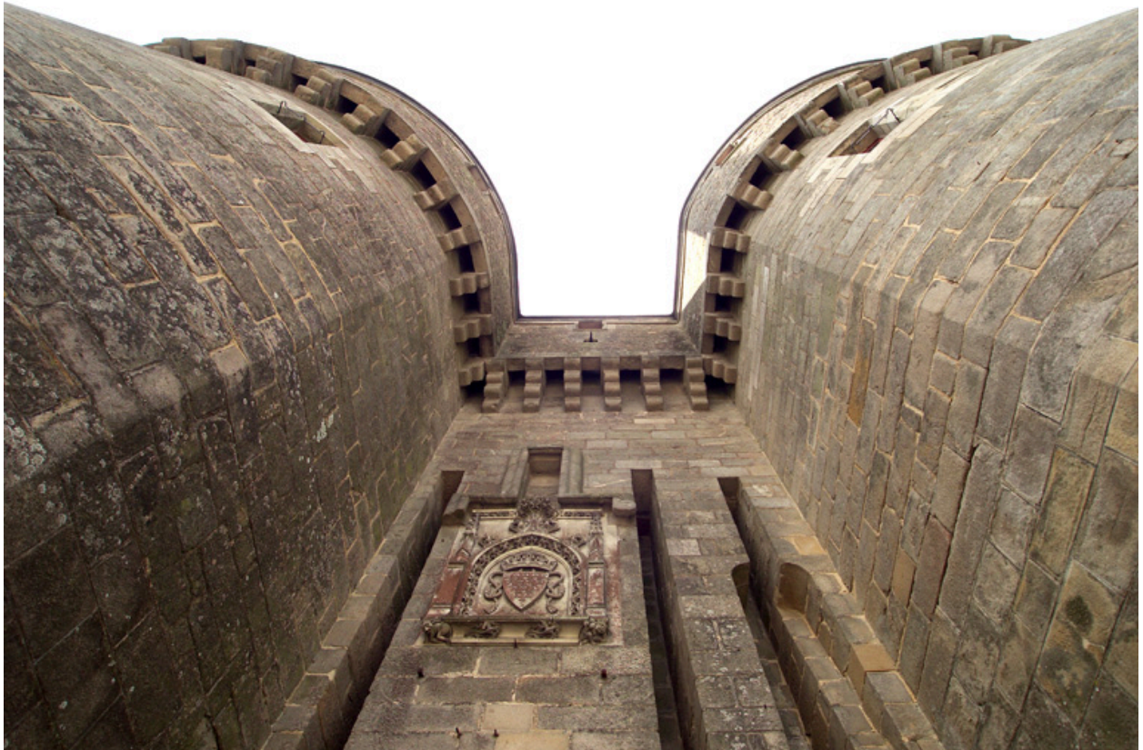
Détail de la face est.
