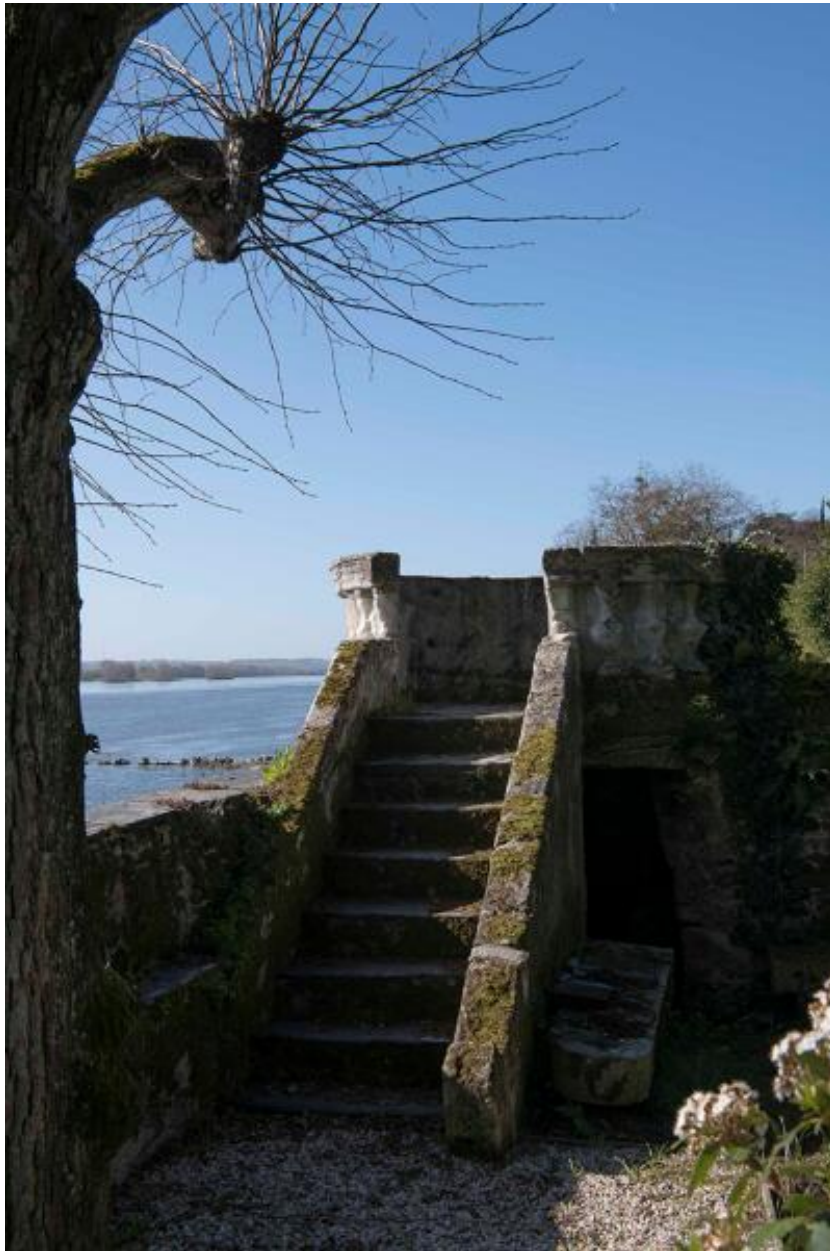
Vue de la tourelle sud depuis la terrasse.
