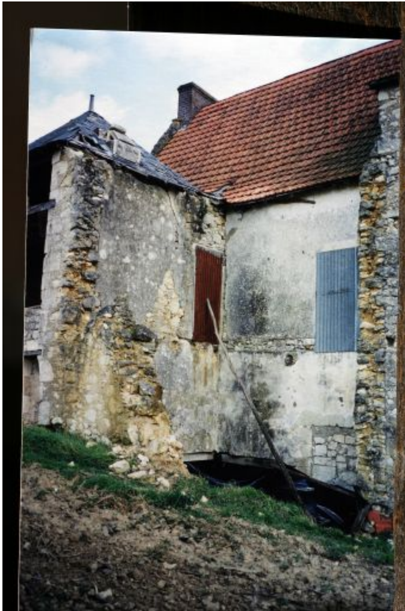
Le pavillon avant travaux de restitution. Photographie (collection particulière).
