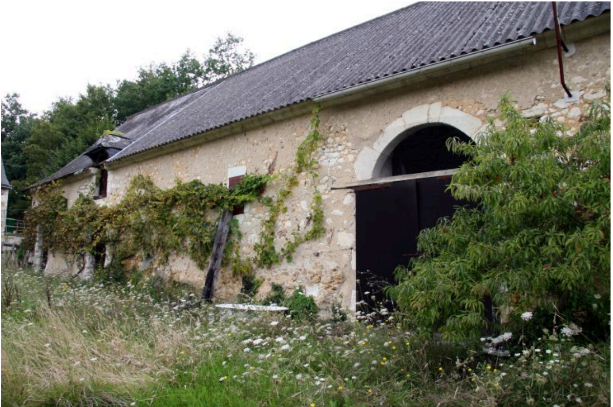
La grange : porte d'entrée.
