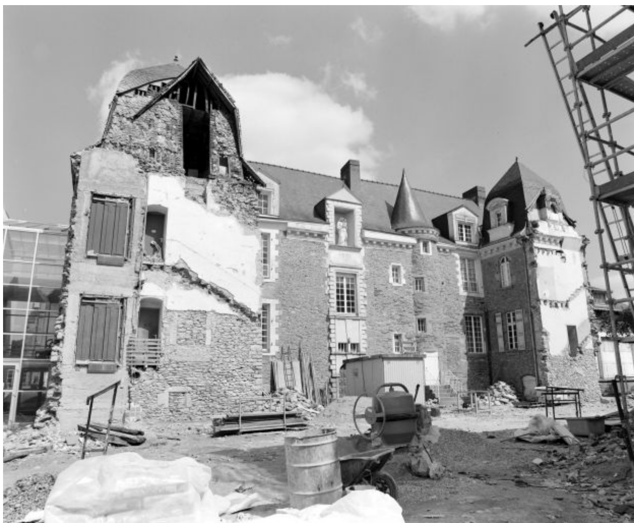
Elévation antérieure sur la cour d'entrée : vue générale après les travaux de 1998.
