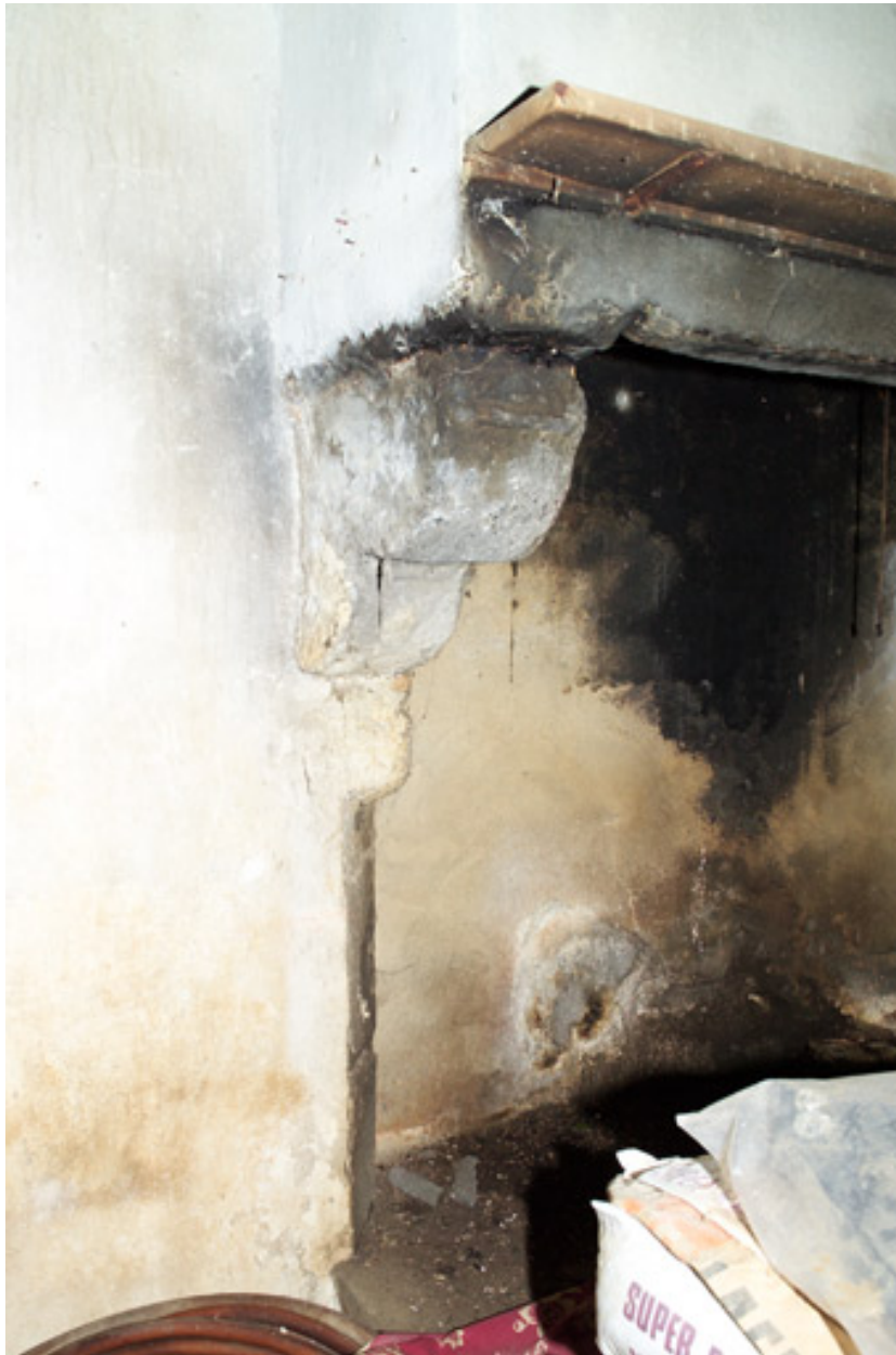
Console gauche de la cheminée de l'avant-dernier logement à l'est.
