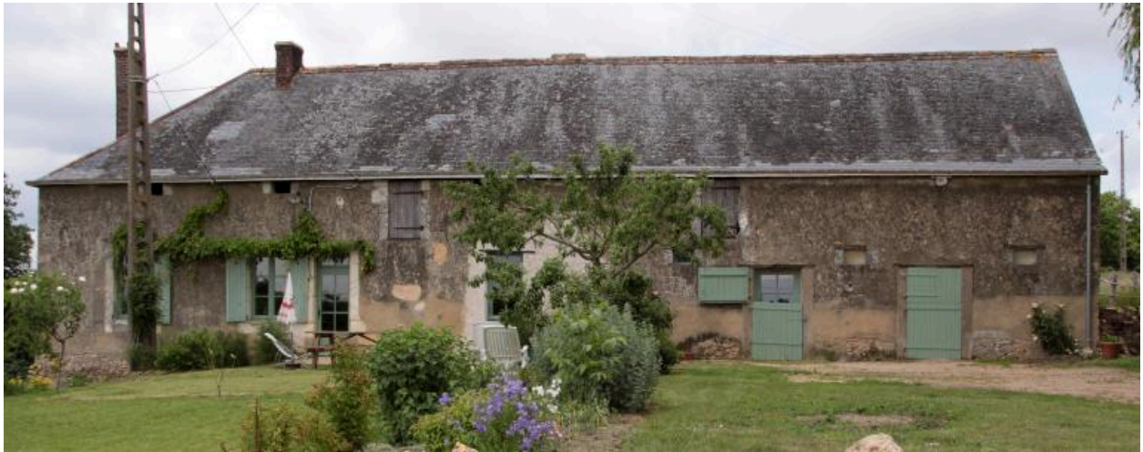
Ferme bloc à terre à haut surcroît. La Gavelière.
