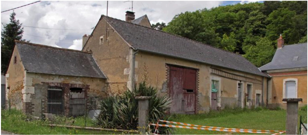
Grange et étables de la maison n° 1, façades sur cour.
