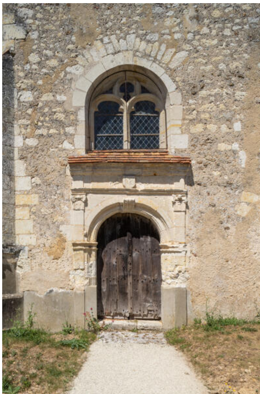
Porte et fenêtre de la chapelle latérale, côté sud.
