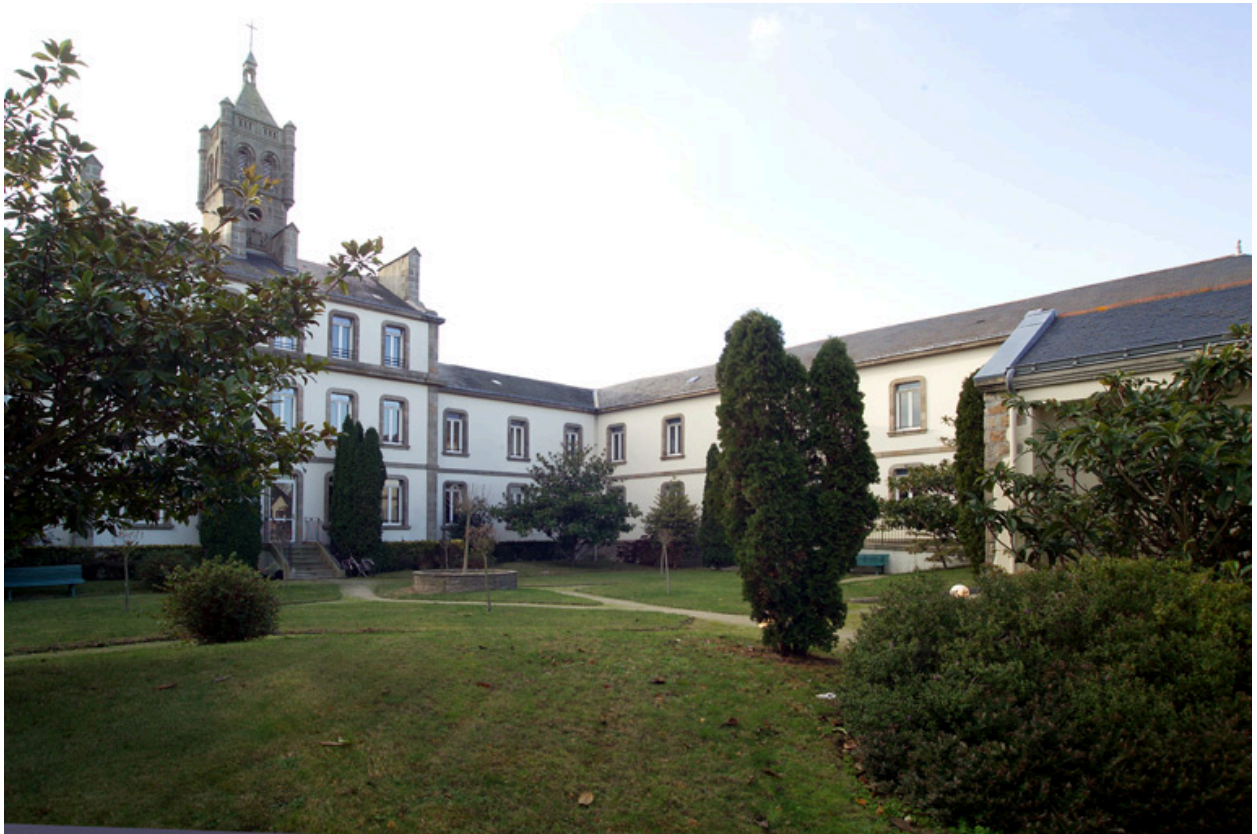
Fond de cour : corps central et aile occidentale vus depuis le nord-est.
