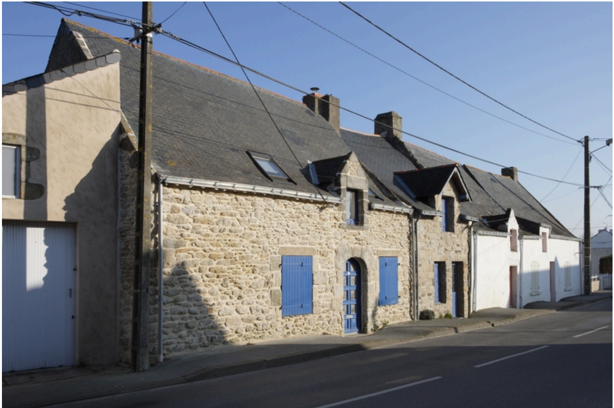
Vue d'ensemble de la rangée depuis le sud-ouest.
