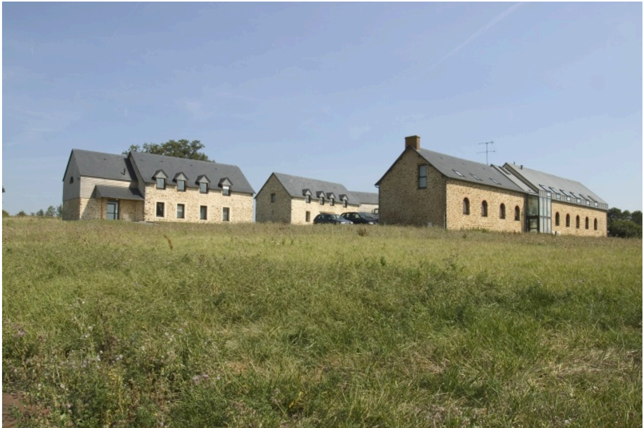
Vue d'ensemble depuis l'ouest. A droite le logis-étable.
