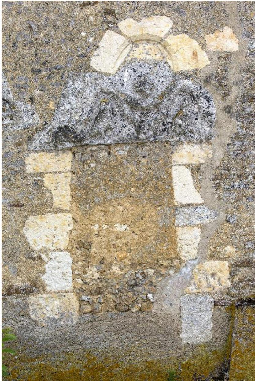
Nef, mur nord, détail : baie murée, éléments de décor mal repositionnés.
