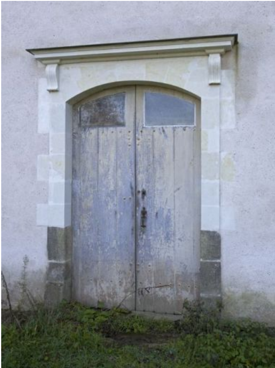
La demeure : façade nord, la porte d'entrée.
