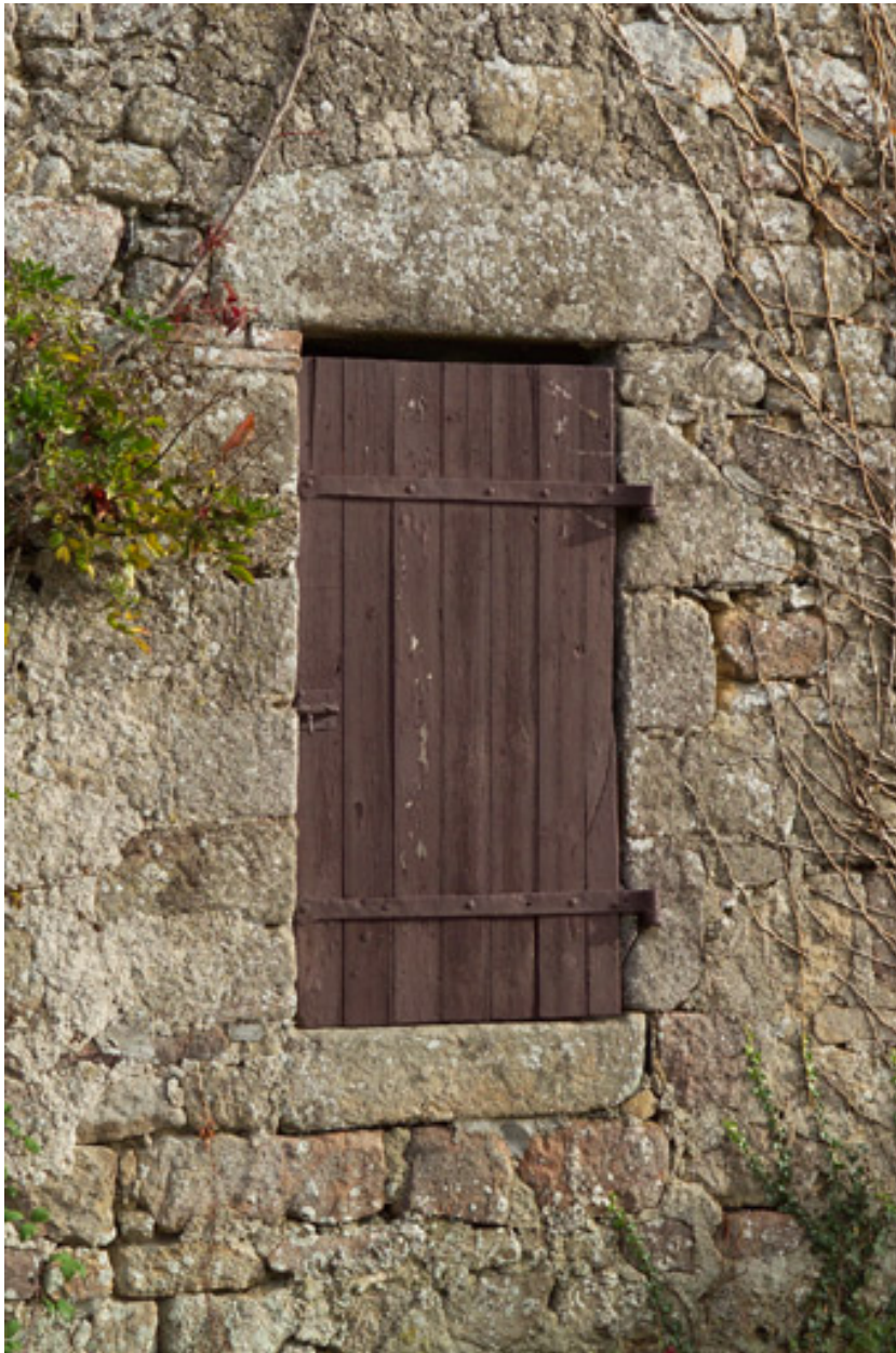
Aile sud, façade sud, détail de porte.
