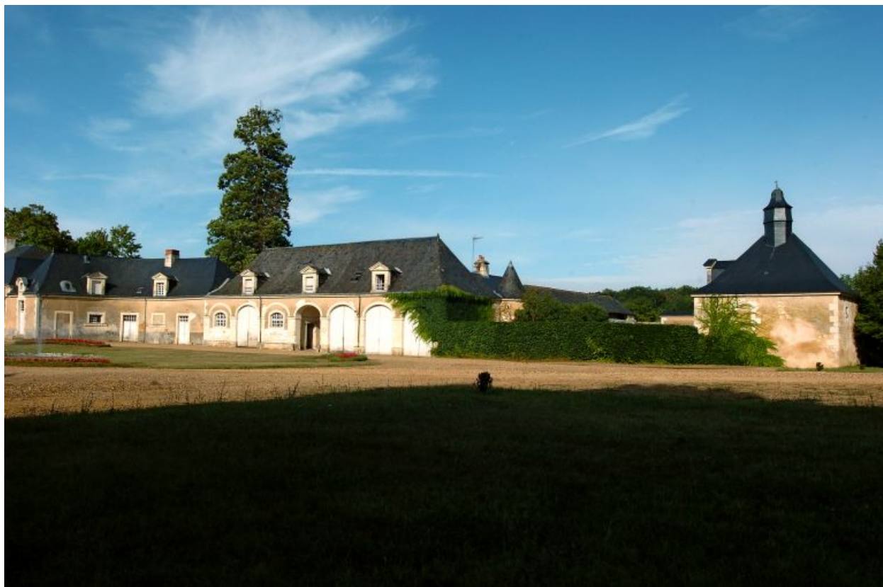
Vue d'ensemble de l'aile droite des communs.
