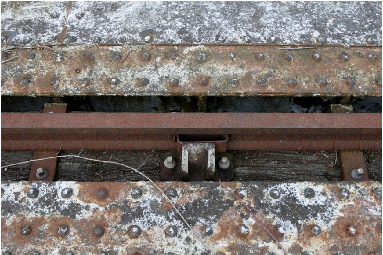
Fixation des rails sur un calage en bois.
